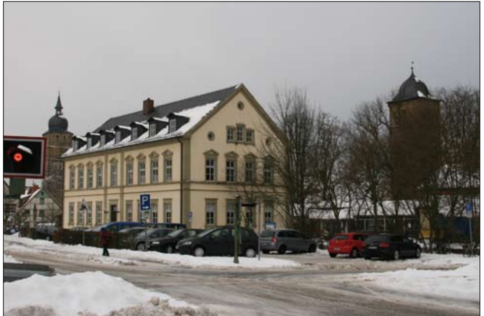
Die Stadt will das Pfarrzentrum zurückkaufen. Auf dem Gelände bis zum Kujathhaus soll auch noch eine Kinderkrippe entstehen. (Foto: Jürgen Hennemann)
